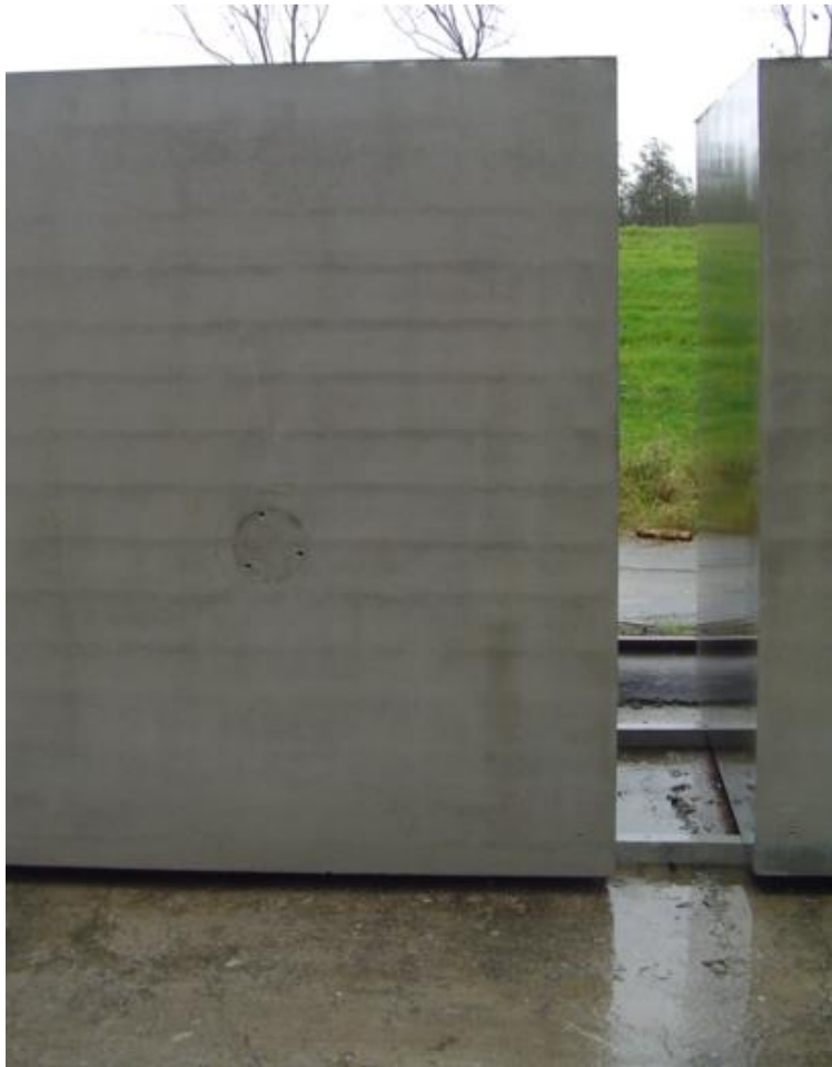
Figuur 5.41 Aftekening van de wapening.
