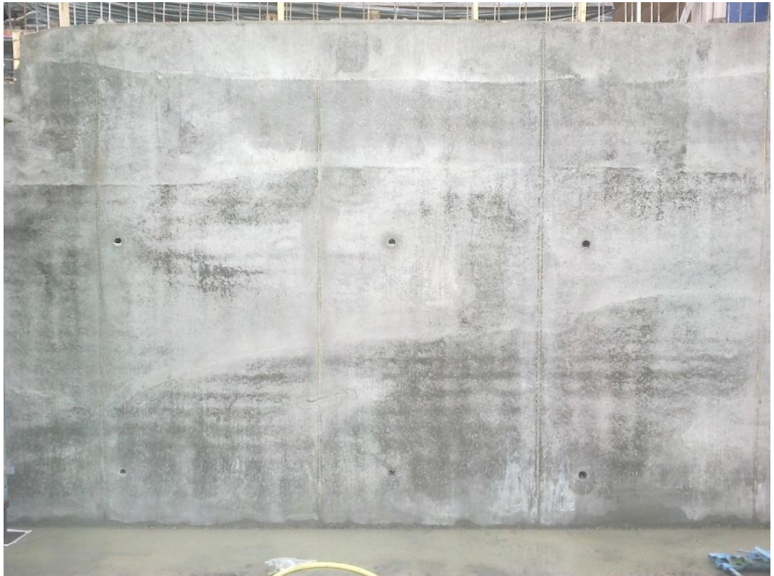
Figuur 5.29 Aftekening van stortlagen.
