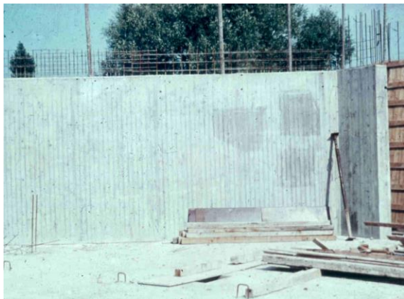
Figuur 5.40 Bekisting hergebruikt, tweede stort zonder sparingen. (Bron Sholz).
