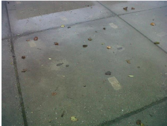
Figuur 5.19 Aftekening stophout op een natte vloerplaat.
