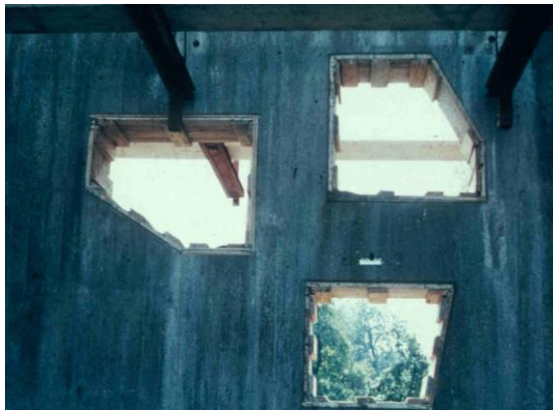
Figuur 5.39 Bekisting eerste stort met sparingen.(Bron Sholz).
