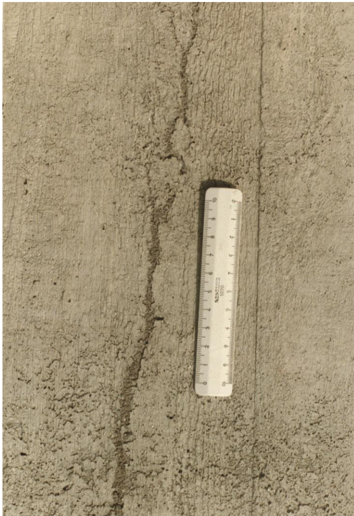
Figuur 5.33 Zandstreep ontsiert het beeld.
